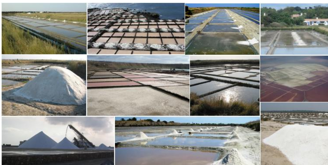
شکل شماره (18): چند نما از استخرهای جمع‌آوری نمک و پوشش کف و روکش عایق‌های پلاستیکی (HDPE Geomembrance) سطح حوضچه جهت ممانعت از نشت و اثر باد در انتقال نمک به اراضی مجاور.
